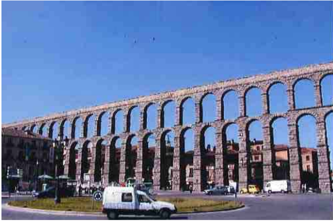
全長 728m高さ 28.9m のローマ水道橋
