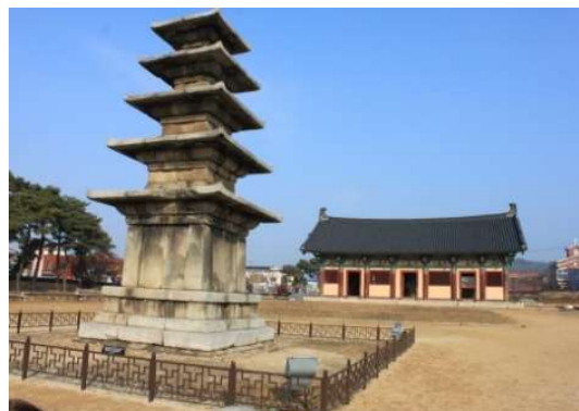
焼け残った石塔と後方の石仏が入った建物
